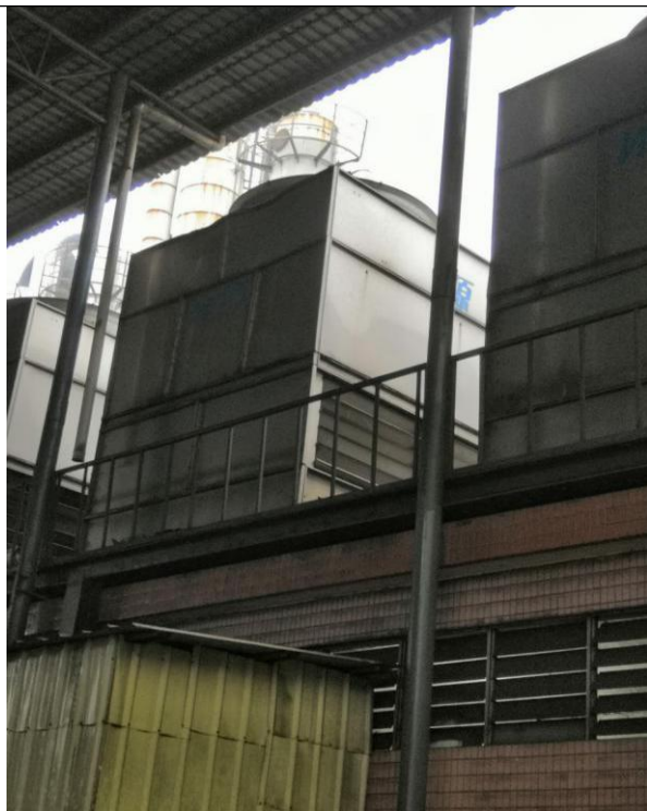
北侧：废水储罐区
