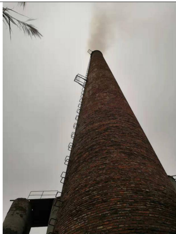
锅炉房现状：45m 高排气筒
