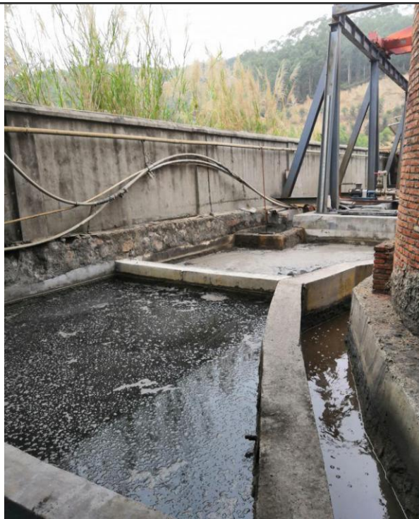
锅炉房现状：循环池
