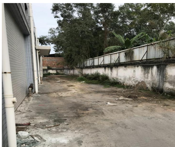
项目东面 厂房
