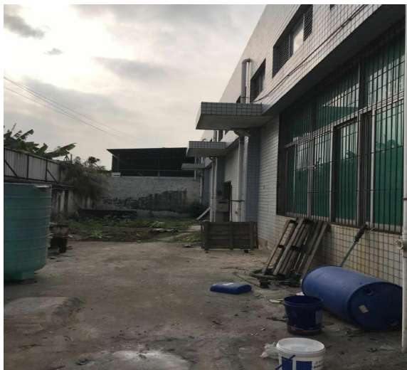
项目西面 厂房
