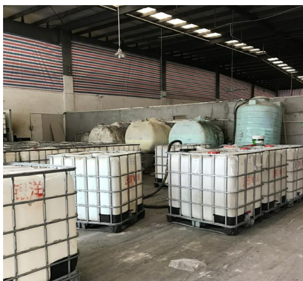
混合搅拌车间
